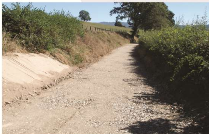
Sur les photos : Chemin Château d'eau - Travaux voirie - Investissement de la commune cette année
